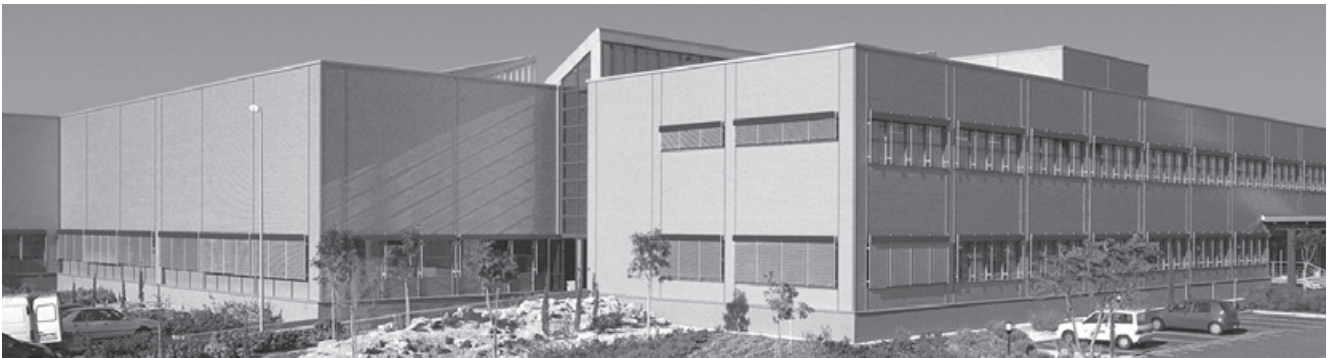
Bosch Fertigungshalle Bari/Italien, Robert Bosch GmbH
